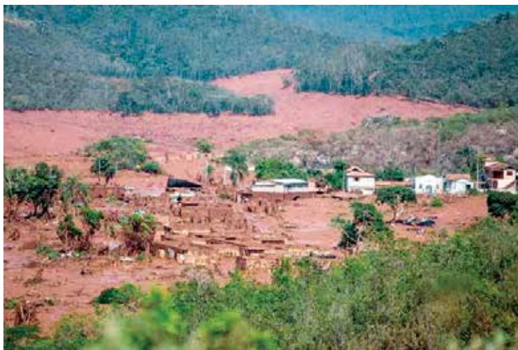
Rompimento da barragem de rejeitos da Mineradora Samarco, no distrito de Bento Rodrigues (Mariana, MG).
